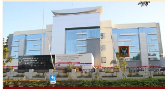
Gedung Pusat Pelayanan Jantung dan Otak Terpadu (CVBC)
